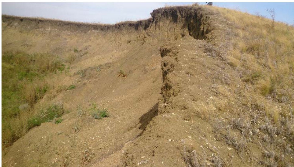
Рис. 2. Овраг на склоновом участке близ с. Новоникольское
